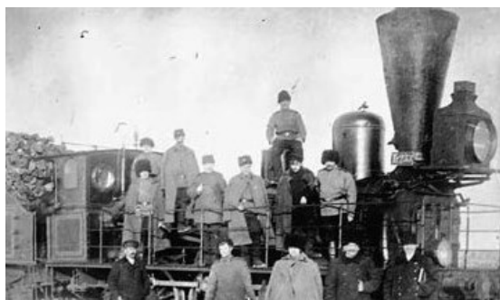
Строительство первой в республике узкоколейки Ижевск — Гольяны
